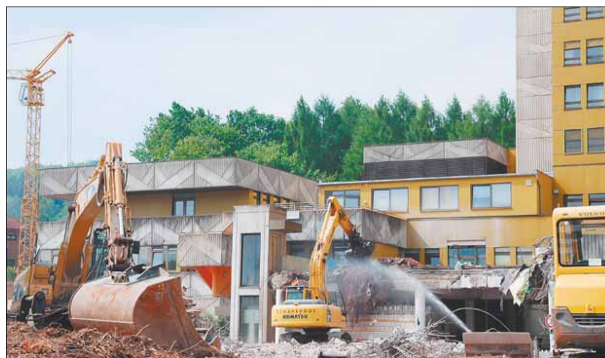
Bagger leisten ganze Arbeit und sorgen für ein neues Erscheinungsbild: Die Betonrampen am Krankenhaus in Höxter sind abgerissen worden, weil ein neuer Eingang entsteht. Foto: Michael Robrecht
